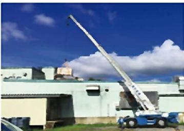
今回の太陽光発電システム設置工事の際に使用した太陽光パネルはクレーンによって、屋根に運びました。244 kWh発電出力なので、今后の活躍が期待です！
